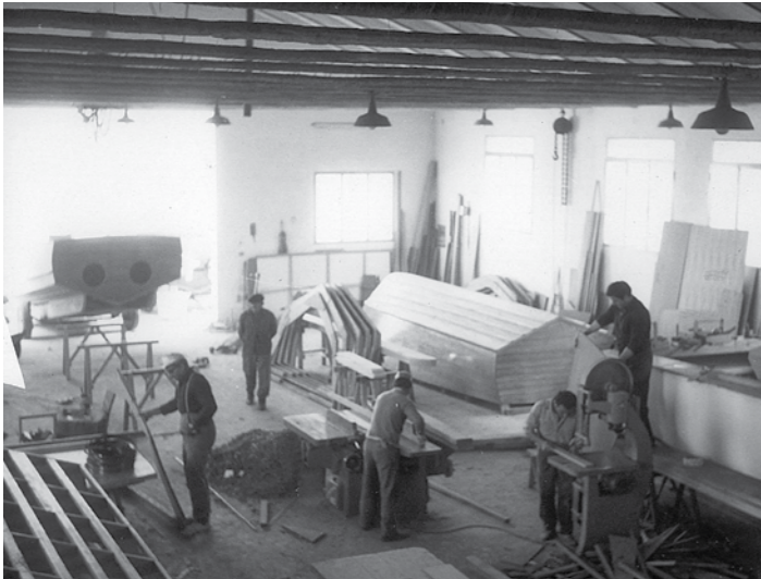
Il terzo cantiere di Giancarlo Dellapasqua, nel 1966.
